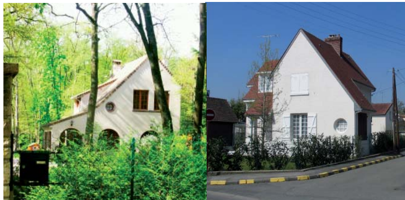
Domaine du Lys et avenue du Maréchal Joffre, un modèle récurrent: les maisons simples, toiture plangente à pans coupés, et oeil de boeuf en façade
