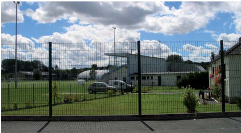
Des espaces libres végétalisés et des bâtiments à faible emprise au sol
