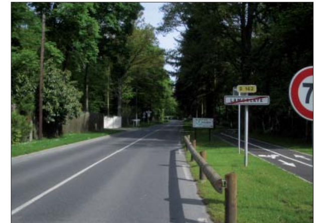
Voie secondaire : RD 162 au nord du territoire communal : le trottoir entièrement enherbé est peu commode pour le piéton
