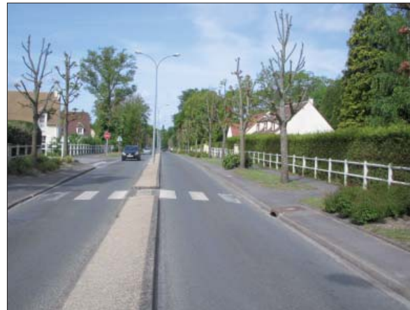
Voie secondaire : Allée des Merisiers : les arbustes en pied des arbres d'alignement rendent le trottoir difficilement praticable
