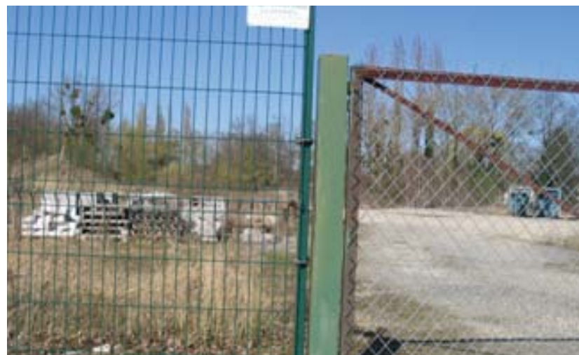
Des perspectives vers des espaces naturels, mais des abords imperméabilisés et dévalorisés
