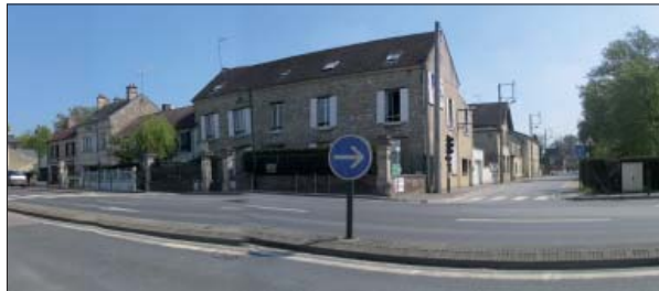
B. Entrée par la rue de la Grange des Prés vers les écuries
