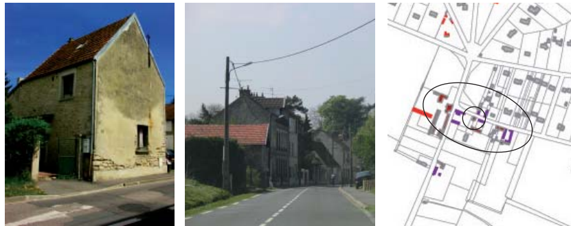
Le hameau du Lys: un bâtiment rural, des alignements sur rue (Av. C. de Gaulle)
