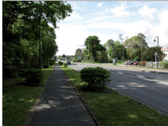
RD 1016 à la hauteur du centre-ville : le piéton est isolé de la chaussée par une bande enherbée
