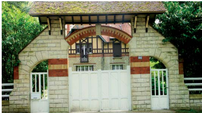
Domaine du Lys: un vocabulaire stylistique du bâti qui se retrouve dans le traitement des clôtures (Base en moellons épais, bichromie de la brique, colombages)
